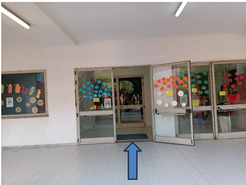
INGRESSO PRINCIPALE SCUOLA PRIMARIA DE AMICIS DI CAGLIARI
