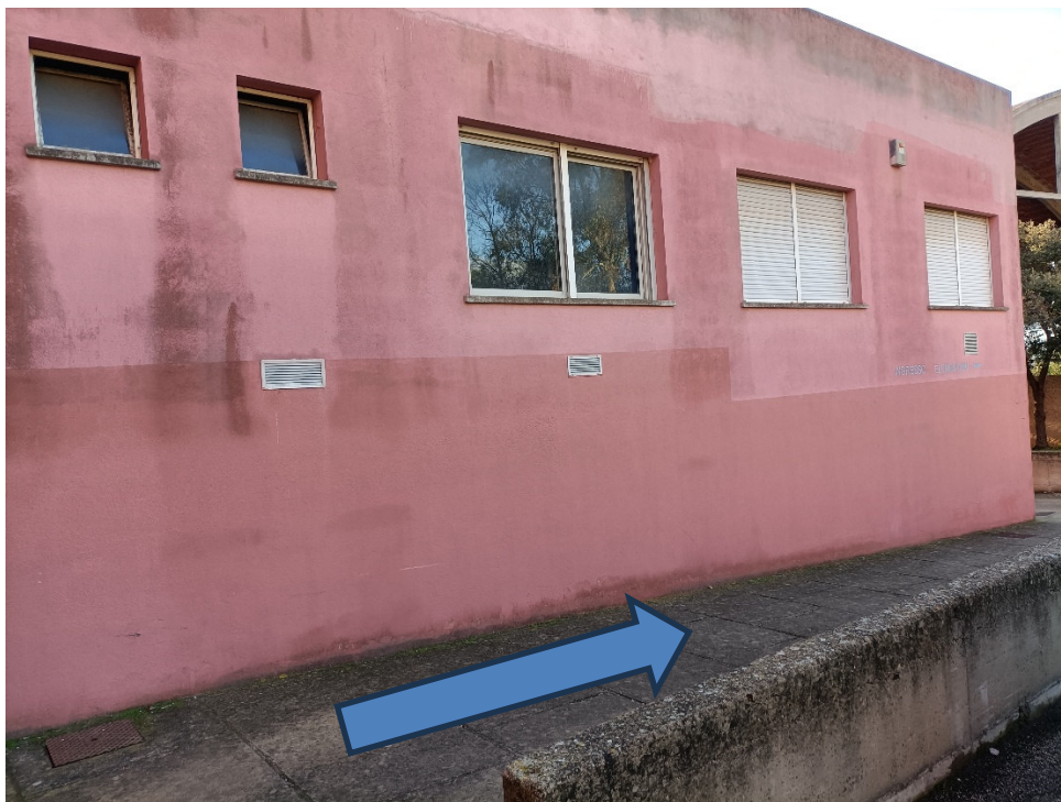
EDIFICIO DE AMICIS, PERCORRERE IL PERCORSO PEDONALE IN DISCESA PER GIUNGERE ALL'INGRESSO DELLA DE AMICIS
